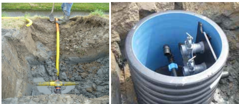
Figuur 73. Aanleg van anti-verziltingsdrainage met doorspoelleiding (links) en peilput (rechts).
