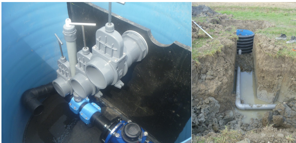
Figuur 41. Inspectie en peilsturingsput.
