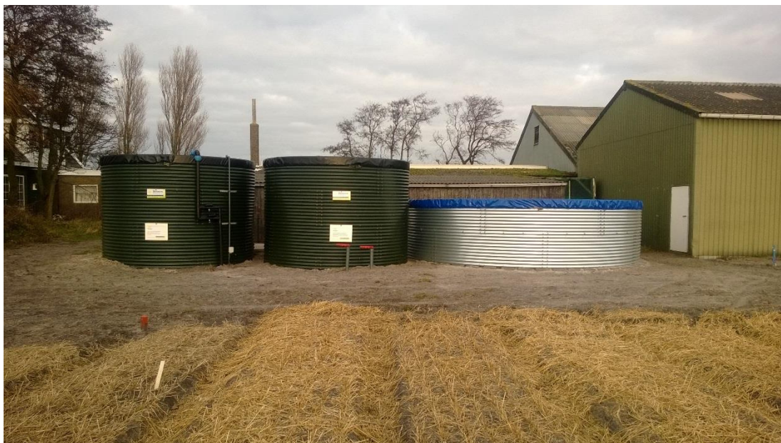
Figuur 6: Overzichtsfoto van het systeem voor ondergrondse opslag te Borgsweer.
